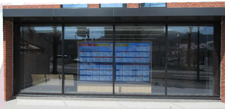
1階ショーウィンドウに大型スクリーンを設置
